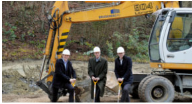
Wasserstoff: Tankstelle in der Ostschweiz
